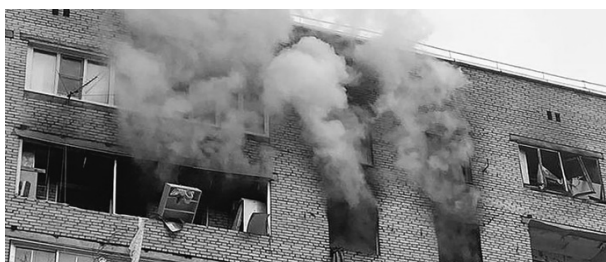
Рис 6. Последствия взрыва бытового газа в г. Химки
