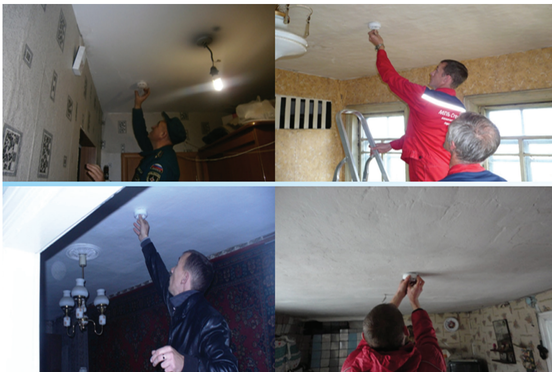
Фото 2. Установка в квартирах автономных дымовых пожарных извещателей.
